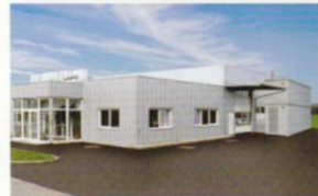
Heiz-Container neben Firmengebäude verputzt, Blechverkleidung oder Holzlatzen.
