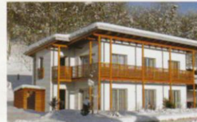
Beton-Heiz-Container direkt an der Wohnhausanlage, mit Holzlatzen Lärche natur verbaut.
