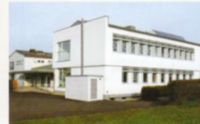
Heiz-Container neben öffentlichem Gebäude, verputzt oder weiße Holzlatzen.
